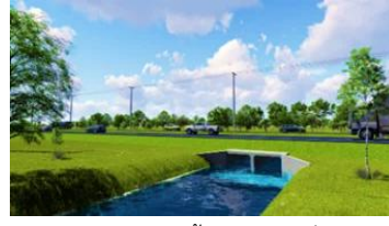
อาคารระบายน้ำแบบท่อเหลี่ยม (Box Culvert)
