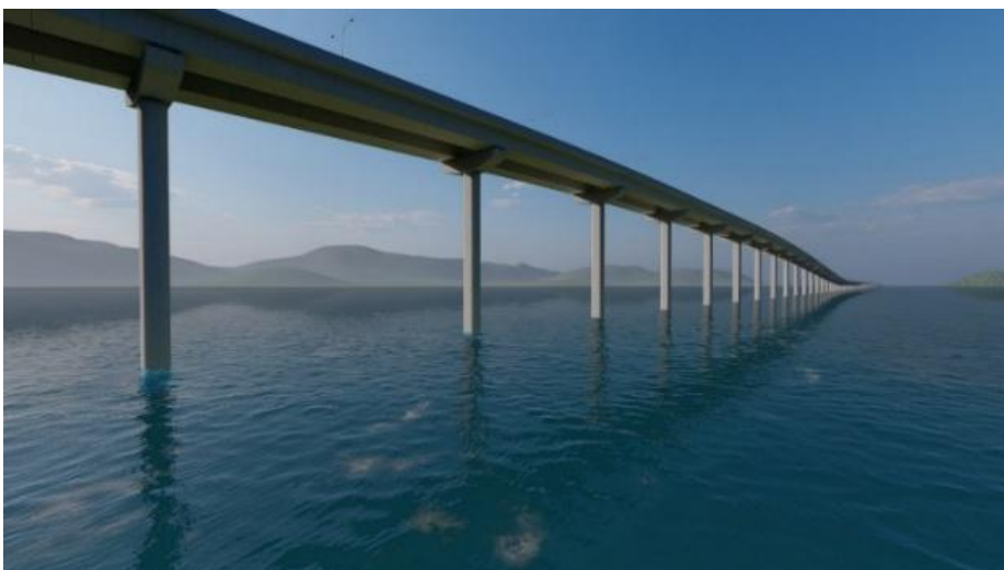
รูปที่ 7-6 รูปแบบสะพานแบบคานรูปกล่อง
