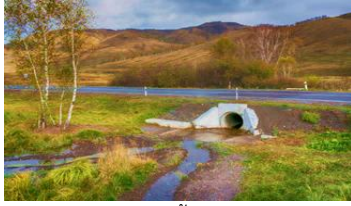
อาคารระบายน้ำแบบท่อกลม (Pipe Culvert)
